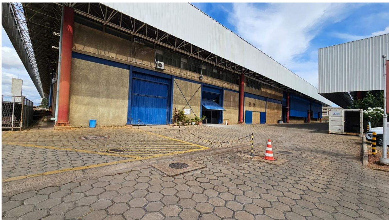
Figura 1 - Prédio onde estão instalados os setores de manutenção.
